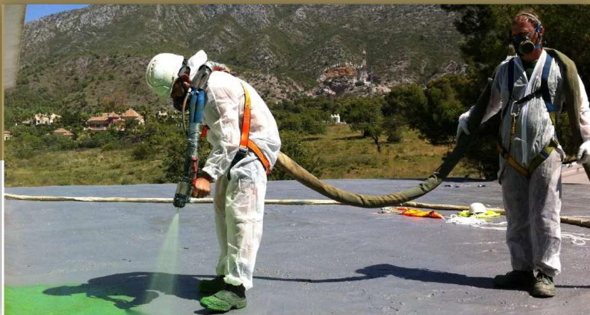
Es una membrana elastomérica bicomponente proyectable 100% sólida y no dañina para el medio ambiente, que una vez aplicada proporciona un recubrimiento impermeabilizante sin juntas, totalmente continuo, adherido al soporte y de alta resistencia.
